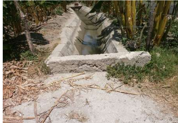
Limpieza finalizada del canal Fundación, Barahona.
