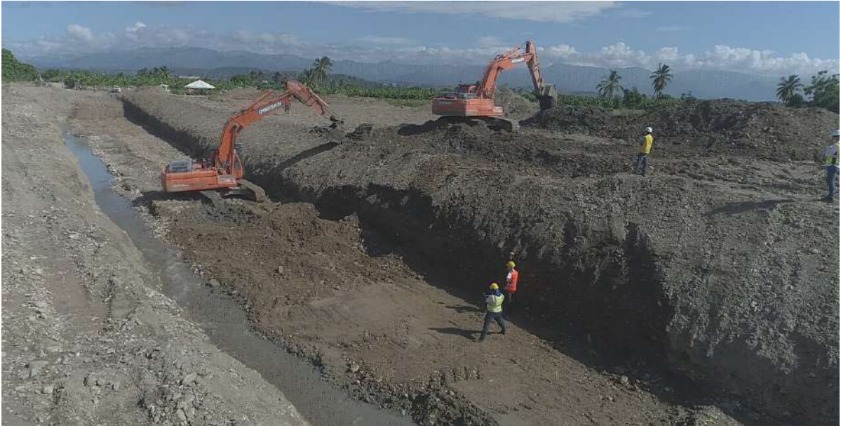
Trabajos de construcción del sifón en el río Tábara, Azua.
