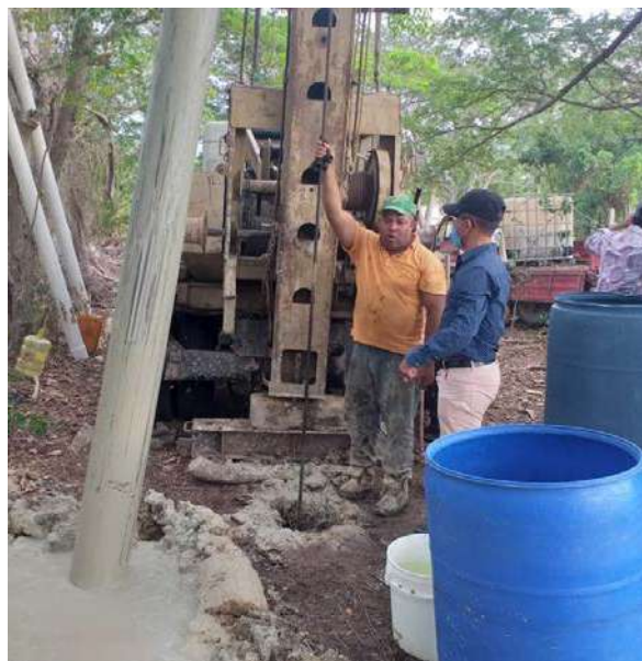
Construcción de pozos tubulares en Estero Hondo, Puerto Plata.
