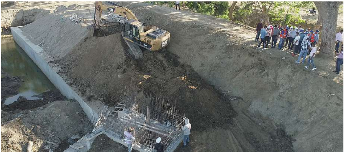
Construcción de una variante a los drenes 1 y 3 en Jaramillo, Montecristi.
