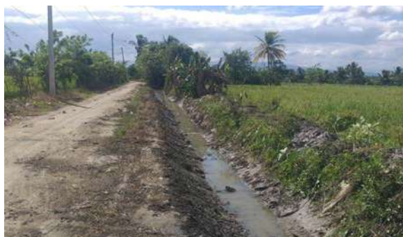
Limpieza de drenaje La Amarga, La Vega.
