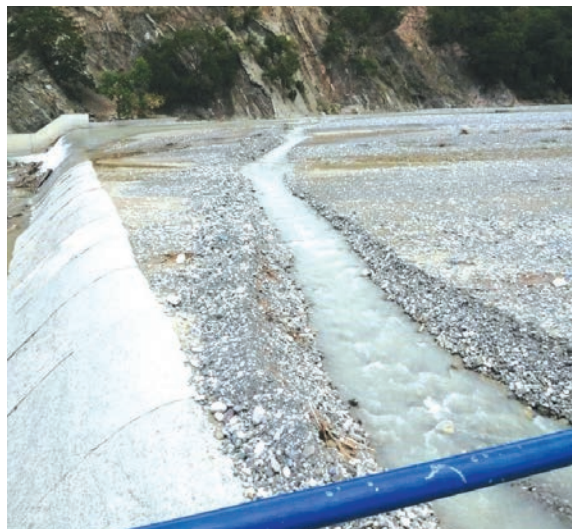
Rehabilitación finalizada de obra de toma directa en el río Ocoa, San José de Ocoa.
