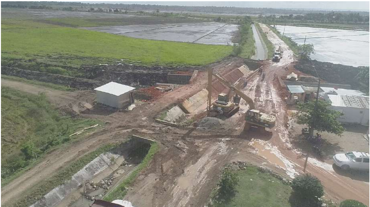
Últimos toques al puente alcantarillado en la Mina de El Aguacate, Bajo Yuna.
