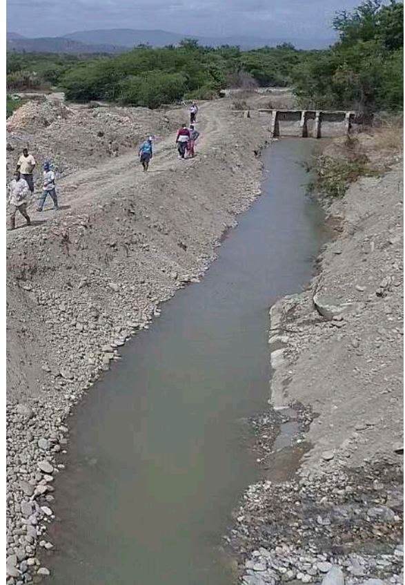
Inspección para la construcción de una alcantarilla de cajón en la cañada Buringa en Vicente Noble, Barahona.
