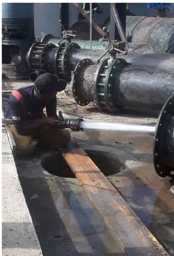
Reparación de equipos de bombeo en la Dirección Regional Alto Yaque del Norte.
