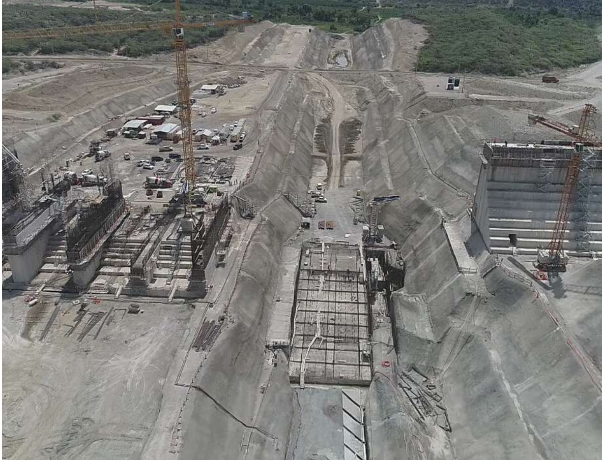
Vista del área donde se construye la presa de Monte Grande, Barahona.
