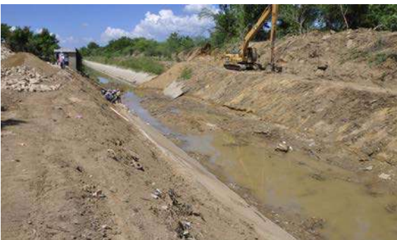
Reparación de un tramo de conducción canal Fernando Valerio, Montecristi.
