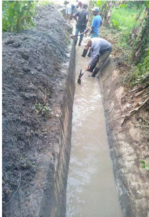
Brigada realizando limpieza manual de canal en la Dirección Regional Valle de San Juan.
