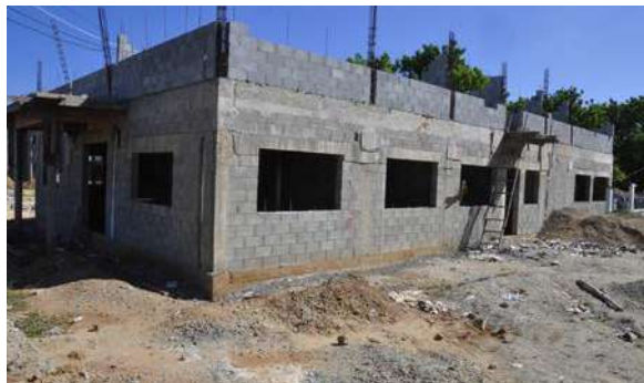
Construcción del nuevo edificio para las oficinas de la Dirección Regional del Sistema Riego Bajo Yaque del Norte
