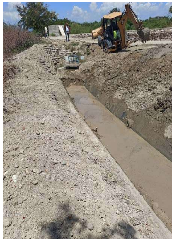
Rehabilitación del canal La Higuera de San Ramón, Tamayo.
