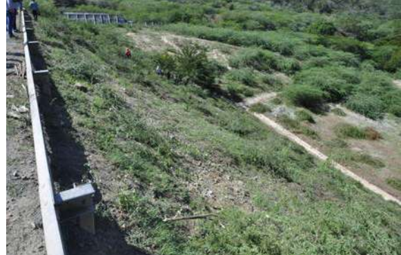
Trabajos de limpieza en Muro de contención de la presa Maguaca, Montecristi.
