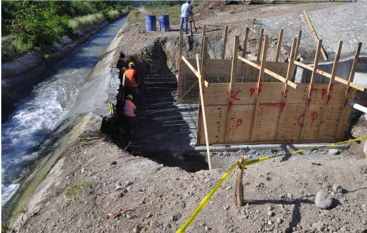
Construcción de la obra de entrada al lateral I, reservorio I, Azua.
