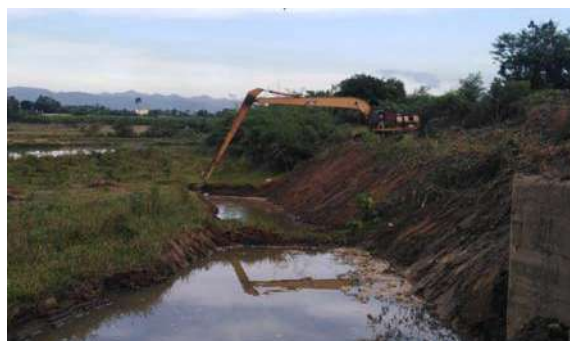
Limpieza de obra de toma canal Camú, La Vega.
