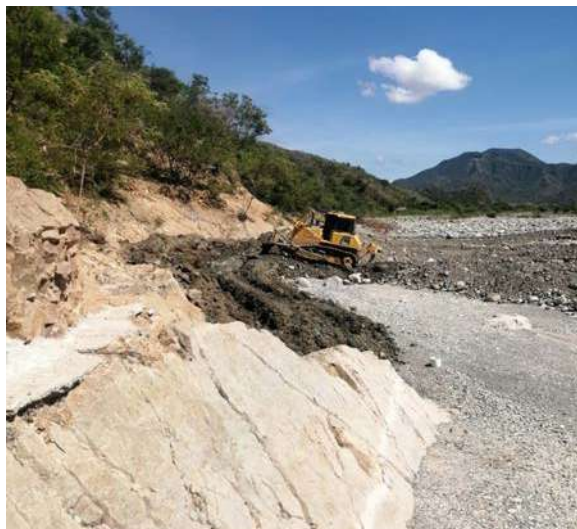
Inicio de rehabilitación de obra de toma directa en el río Ocoa, San José de Ocoa.
