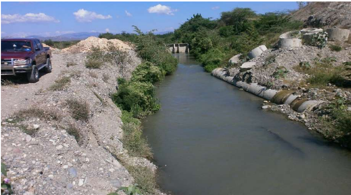
Trabajos de reconstrucción finalizados canal Vicente Noble, Barahona.
