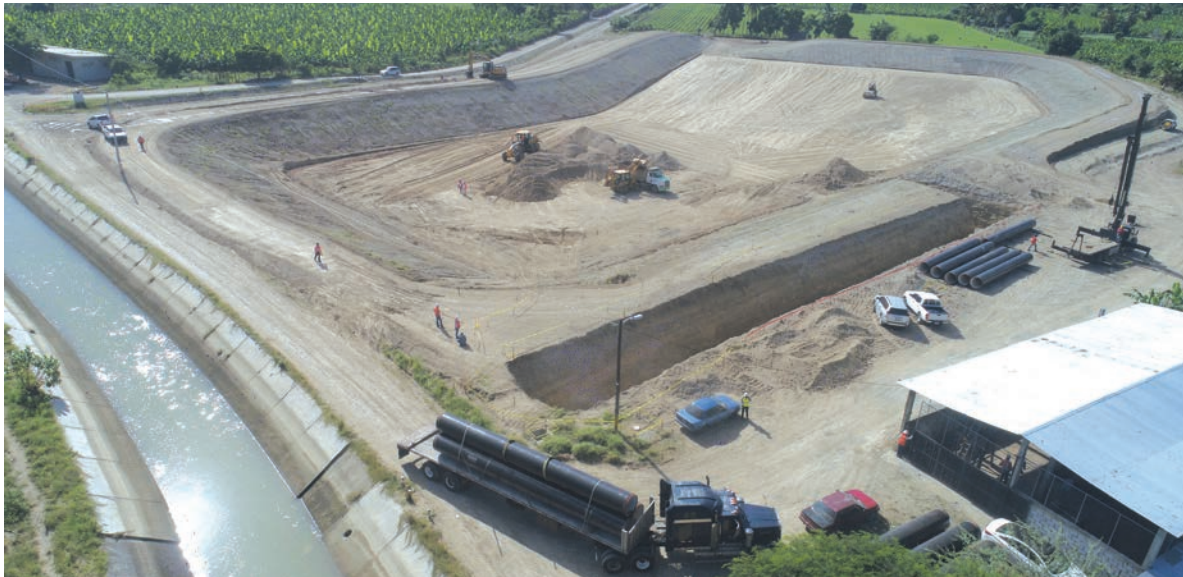
Avances de trabajos en reservorio II, Azua.
