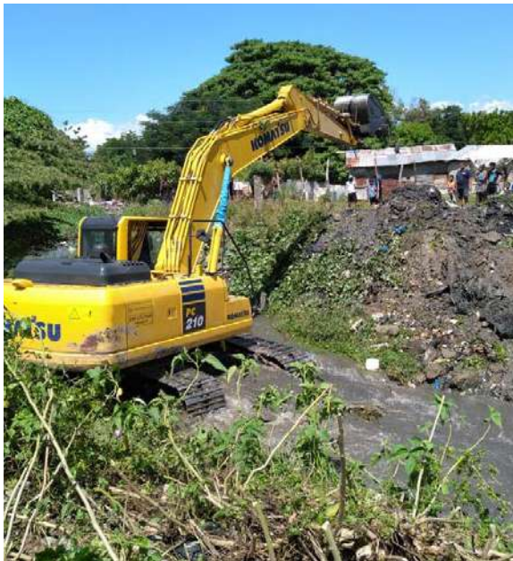
Limpieza de canal con retroexcavadora, Las Ovejas, San Juan.
